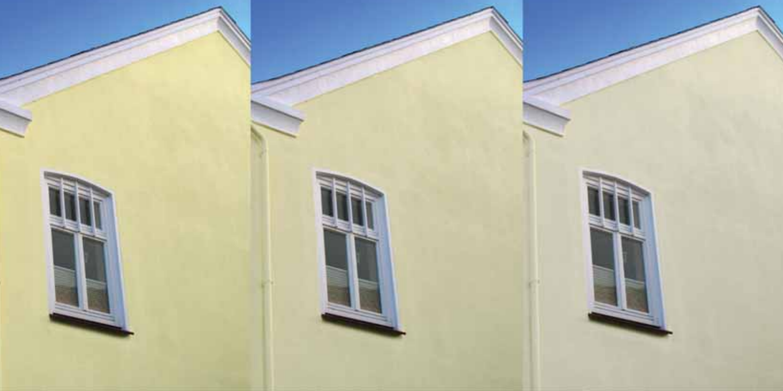
Obr. Znáznornenie zmeny farebnosti fasády bez omietky Anti-Agingputz po 2, 6 a 12 rokoch
